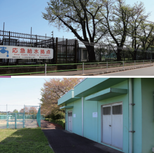
◀左写真上：PFAS 基準値超えのため揚水停止中の上水南給水所（小平市上水南町） 左写真下：配水池の上部は小金井市のテニスコート場になっている
